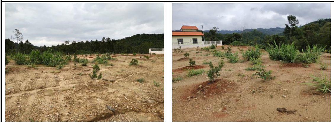
施工生产生活区
