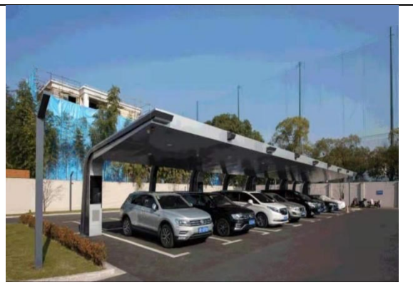
图 10.1-2 某地智慧光伏车棚
