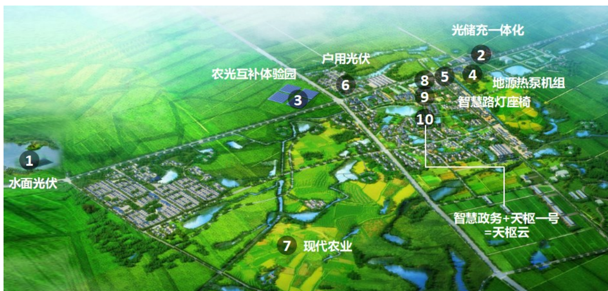
图 10.1-5 安徽小岗村美丽乡村综合智慧能源项目
