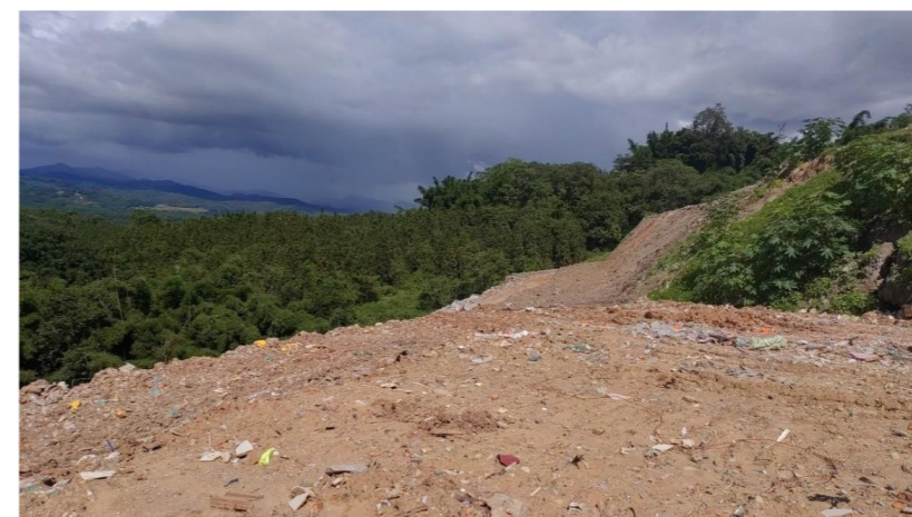
图 2.1-1 瑞丽市建筑垃圾消纳场现场照片
